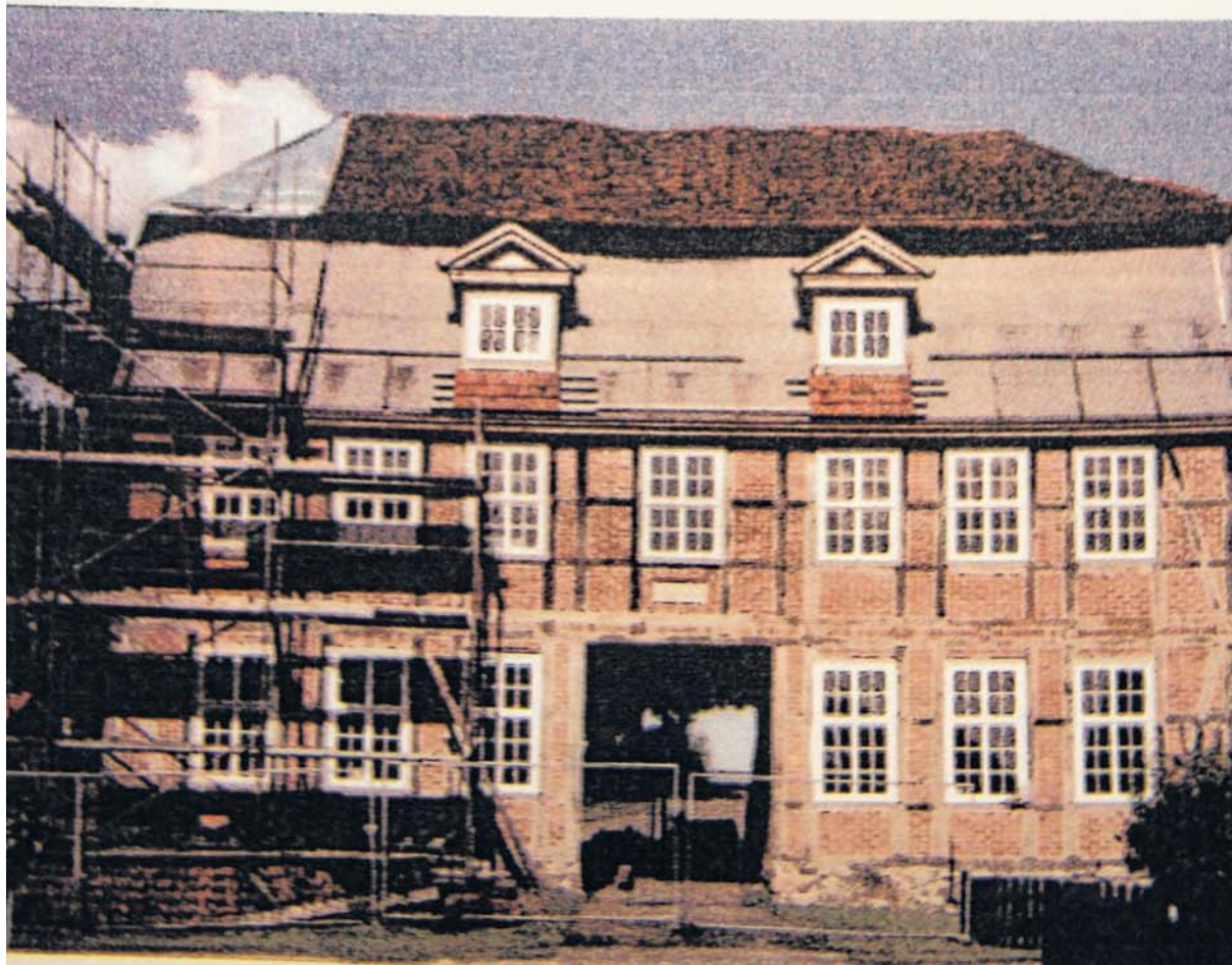
Das barocke Torhaus Woosten diente zu DDR-Zeit als LPG-Lager und sollte als „Schandfleck“ abgerissen werden. Dabei gilt es als landesweit einmalig. Ein Bauherr hat sich seiner mit viel Eigenleistung angenommen. REPRO: NK
